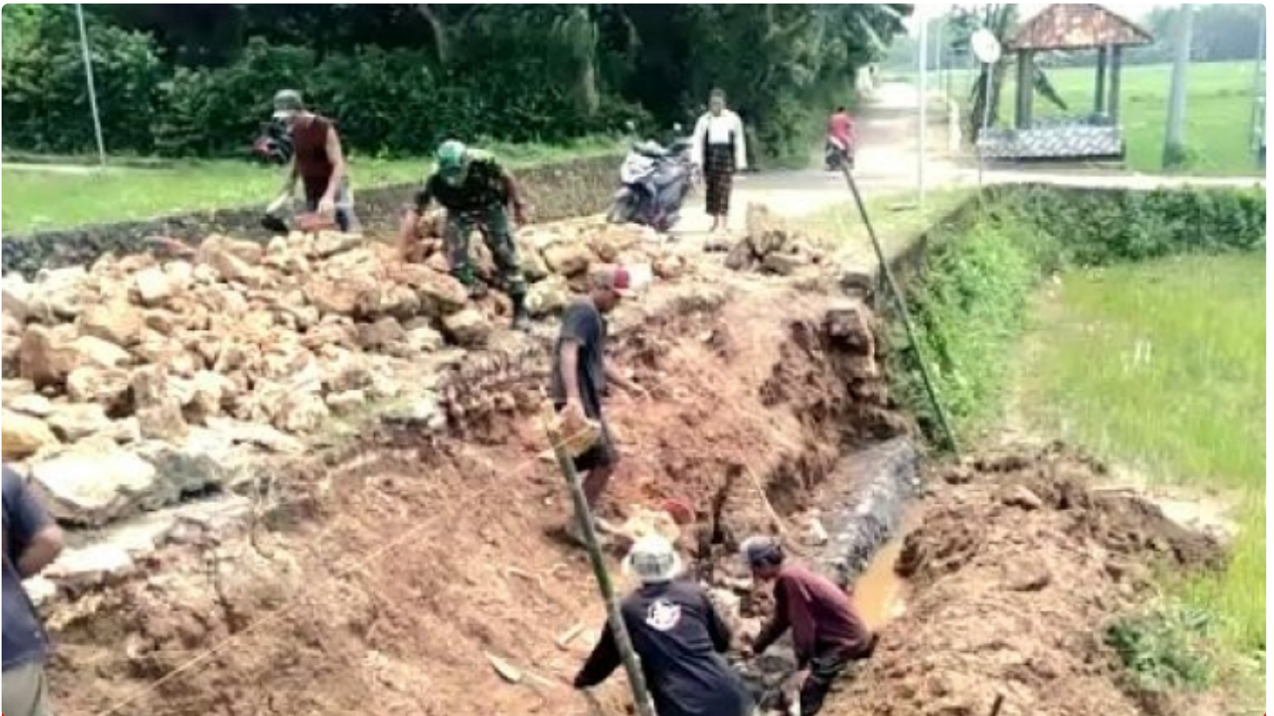
Karya Bakti pembuatan plengsengan penahan jalan
